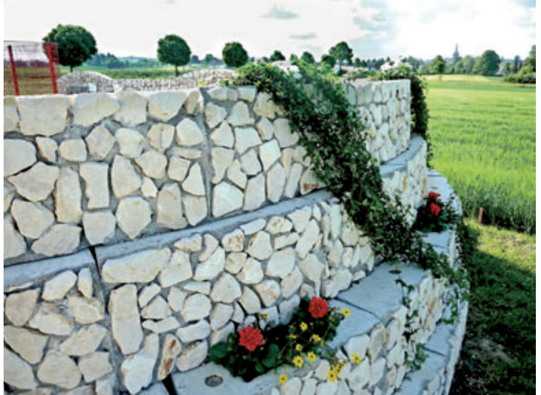
Mauer für abfallendes Gelände Quader, rund versetzt, mit integrierten Blumentrögen
