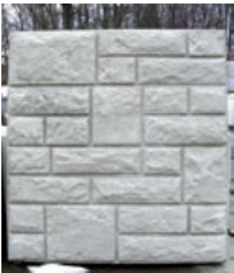
Beton-Stützmauer mit Muster
